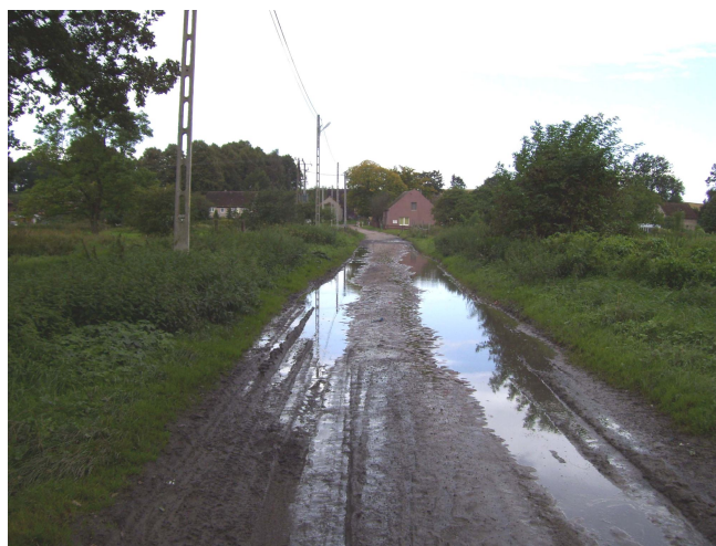
Droga gminna we wsi Upadły proponowana do modernizacji.
