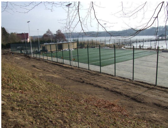
Kompleks boisk „Orlik 2012” przy ul. Szkolne (w trakcie budowy).
