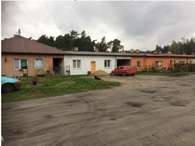
Fot. Sosnowice – budynki mieszkalne (aut. Tomasz Czubara)
